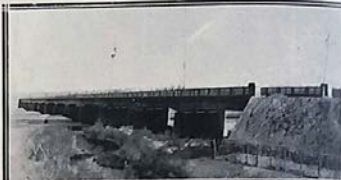
Puente sobre el Río Tunuyán, en Rivadavia, frente al Distrito La Libertad.
