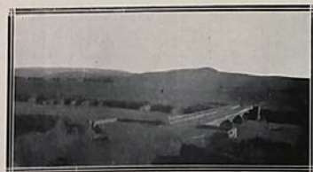
Puente sobre el río Atuel, en el camino del Soneado a Mardaga. Ruta N° 40.
