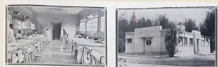
Interior de un pabellón del Hospital San Antonio, recientemente construido, dentro del plan de obras hospitalarias, con la más absoluta higiene y amplitud.
