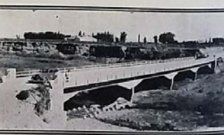
Puente sobre el Zanjón La Nora, en el Departamento San Rafael.
