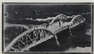
El espléndido puente inaugurado el domingo 20 sobre el Río Atuel y que traduce un hermoso anhelado de aquella rica zona del Sud.
