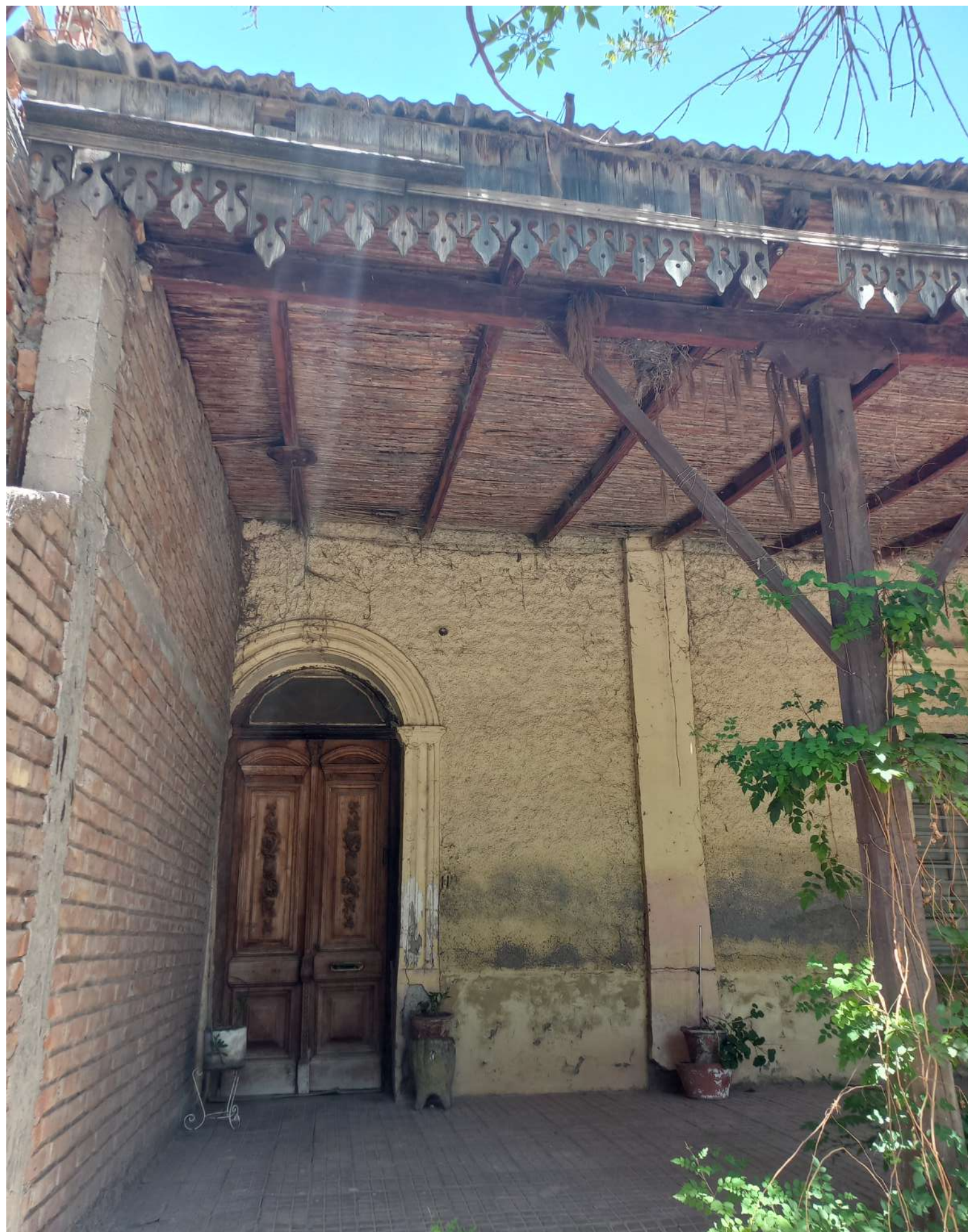
Detalle ingreso y cubierta. Fuente: arq. Paula Martedi.
