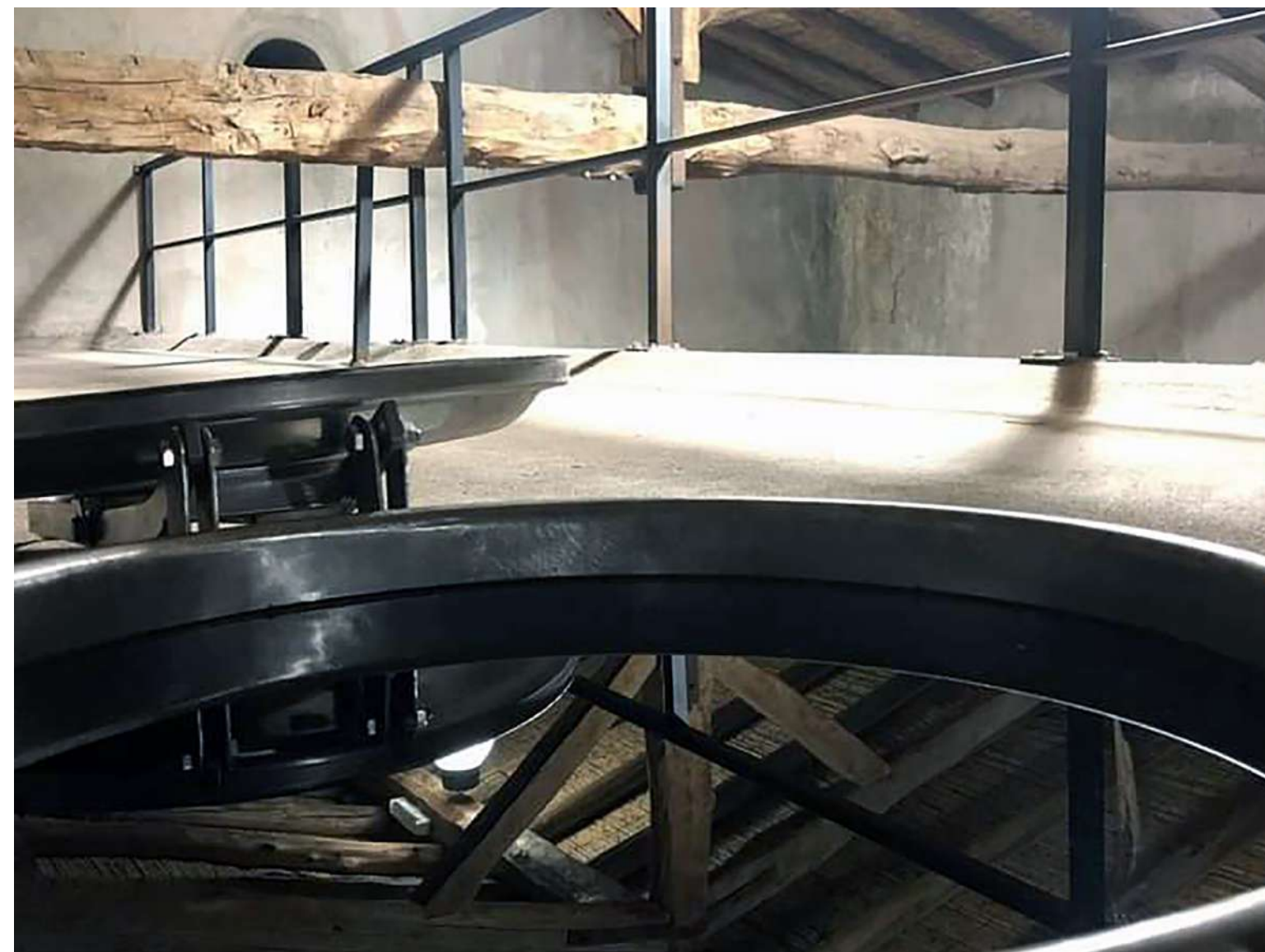
Detalle de cubierta de madera. Fuente: gentileza Sr. Raúl Iudica.
