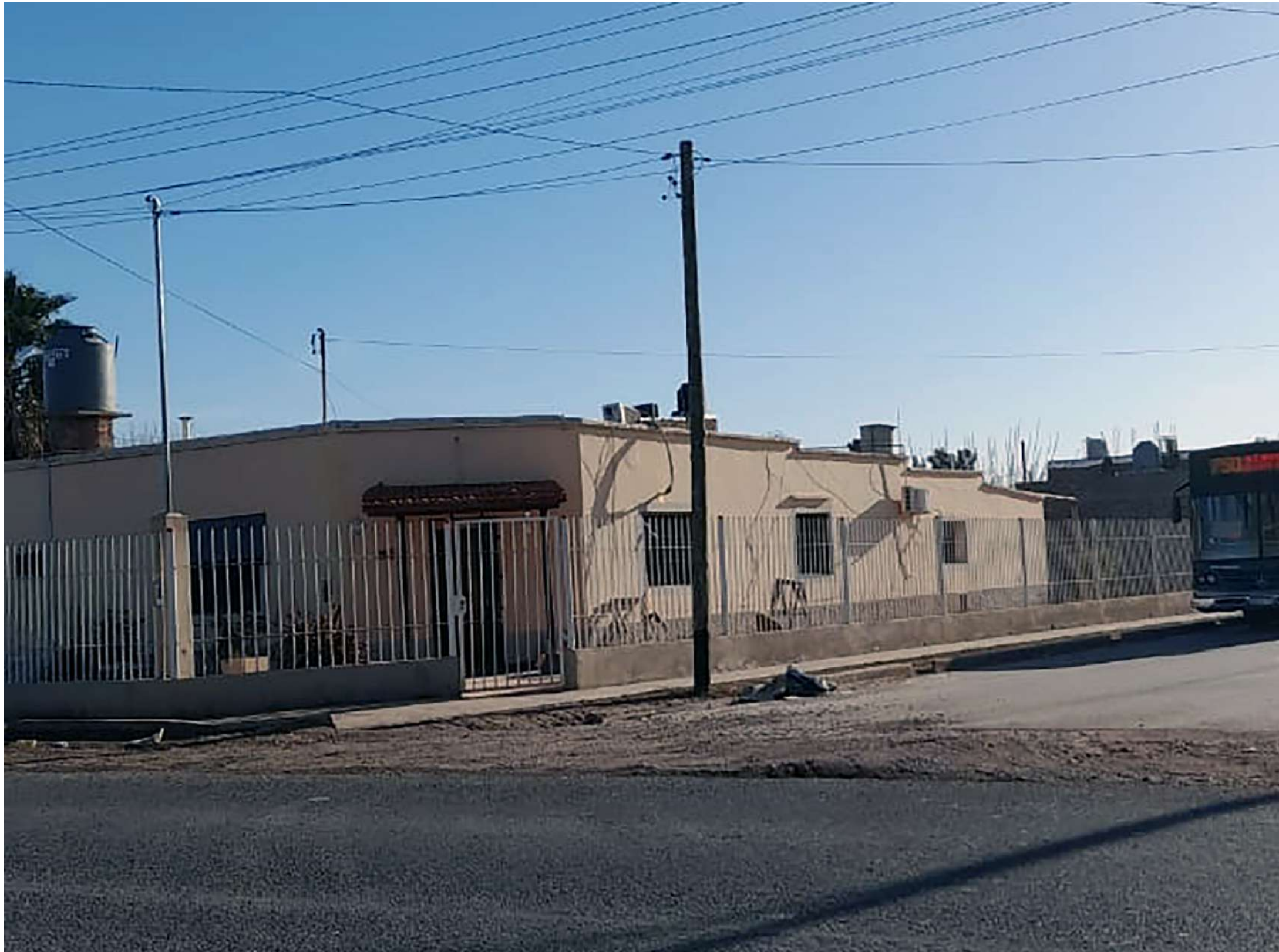
Fachada de almacén RP 50 y Pablo Loos . Fuente: arq. Paula Martedi
