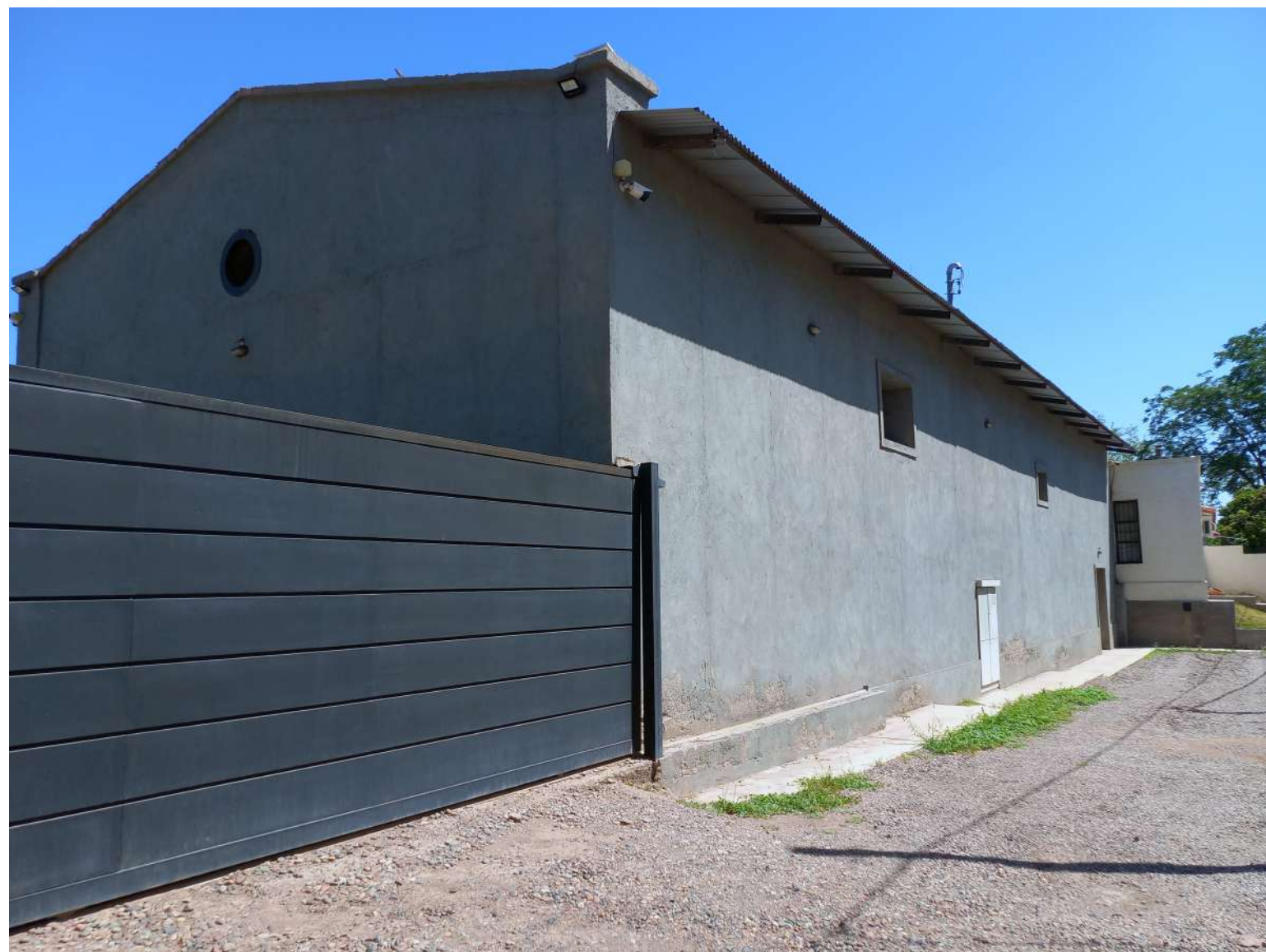
Nave de bodega. Fuente: arq. Paula Martedi.
