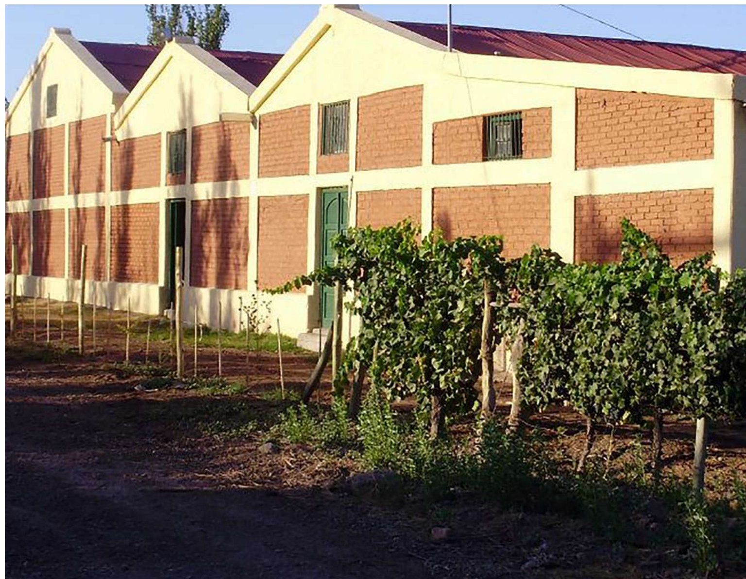
Naves de bodega. Fuente: página de Facebook "Bodega Pircas 1905".
