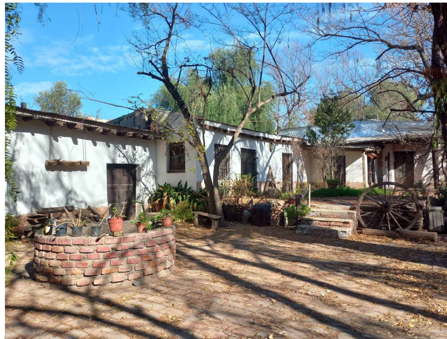
Vista frontal de la vivienda. Fuente: arq. Paula Martedi.
