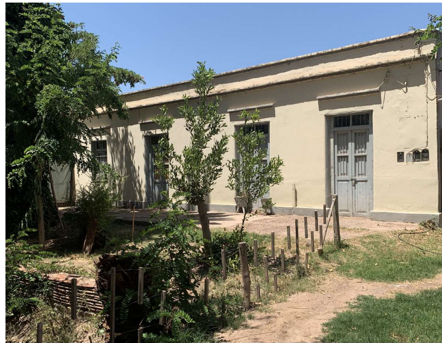
Fachada principal de almacén por Carril Nacional Viejo. Fuente: arq. Paula Martedi.
