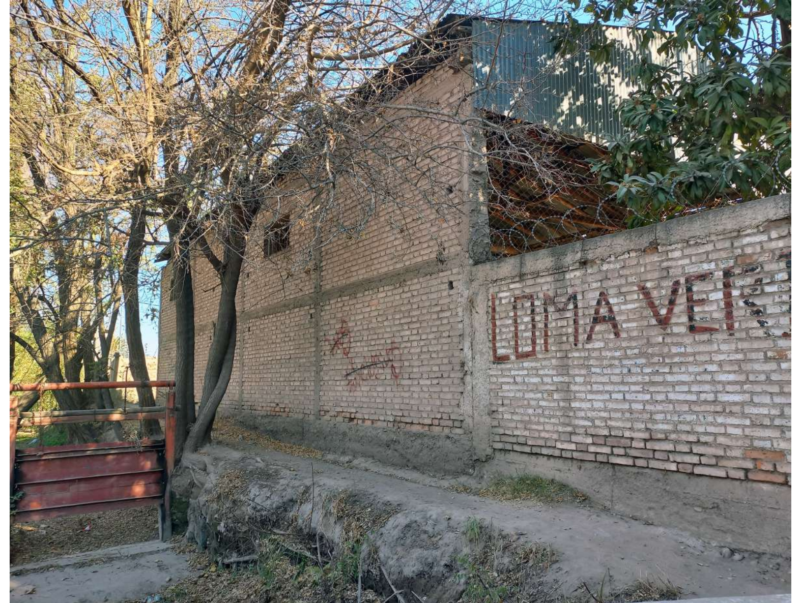
Construcción vinculada a bodega, vista desde calle Lamadrid Norte. Fuente: arq. Paula Martedi.
