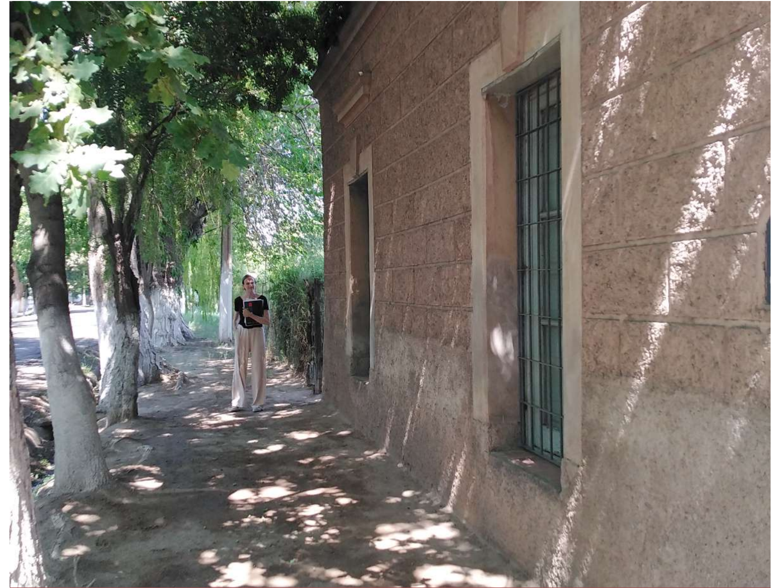
Fachada principal por calle Lamadrid. Fuente: arq. Matías Esteves.
