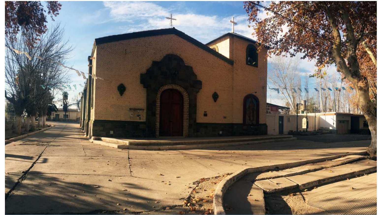
Fachada de acceso a la parroquia, calle 12 de octubre. Fuente: arq. Paula Martedi.
