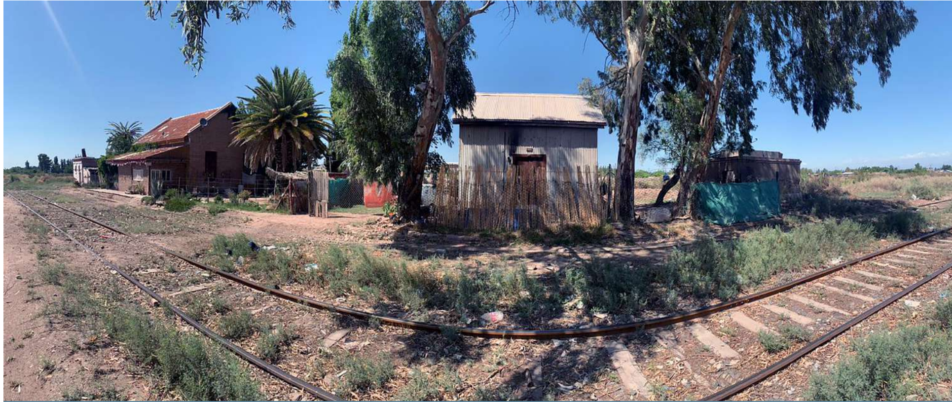
Conjunto de la estación Barcala. Fuente: arq. Paula Martedi.
