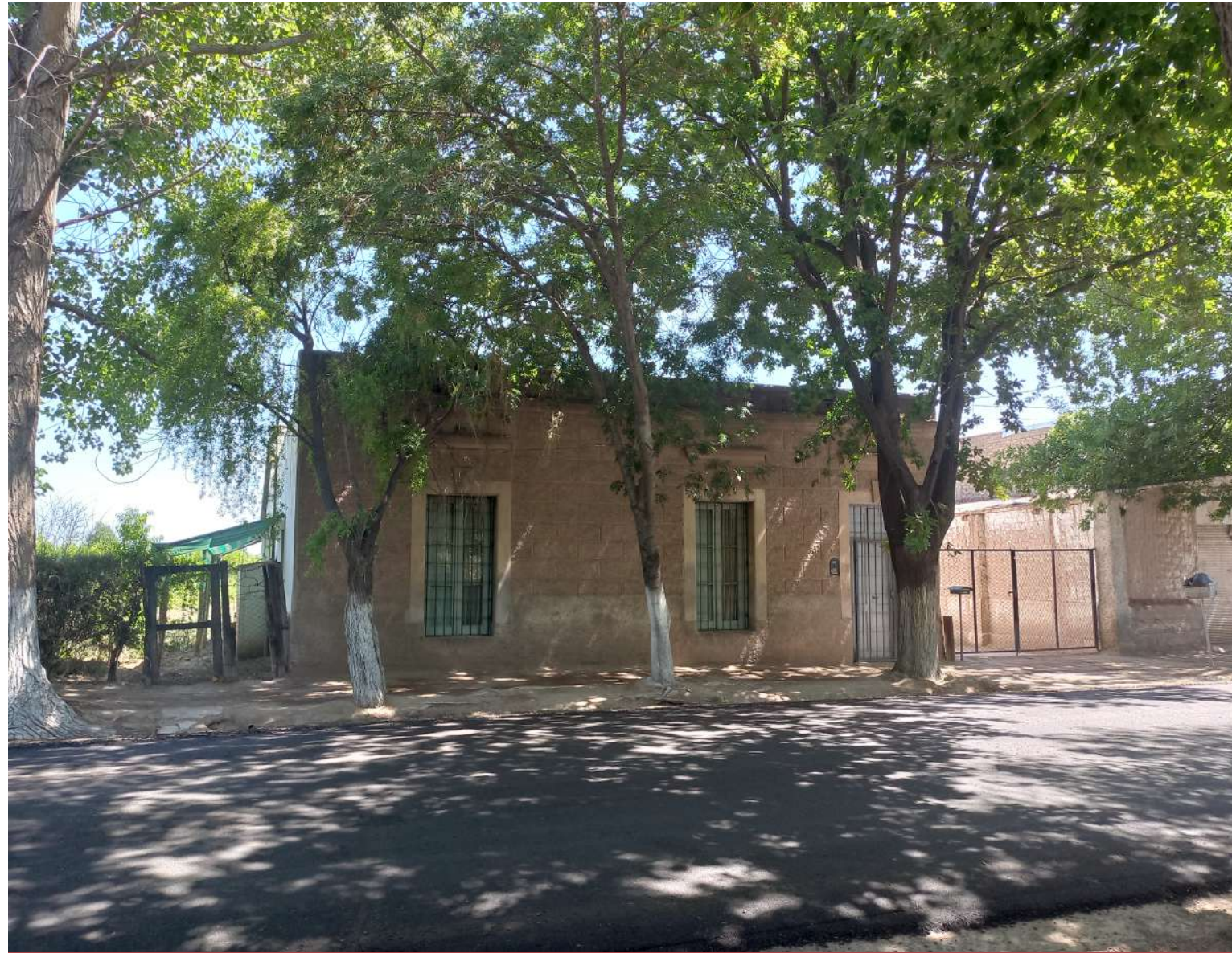
Fachada principal por calle Lamadrid. Fuente: arq. Paula Martedi.
