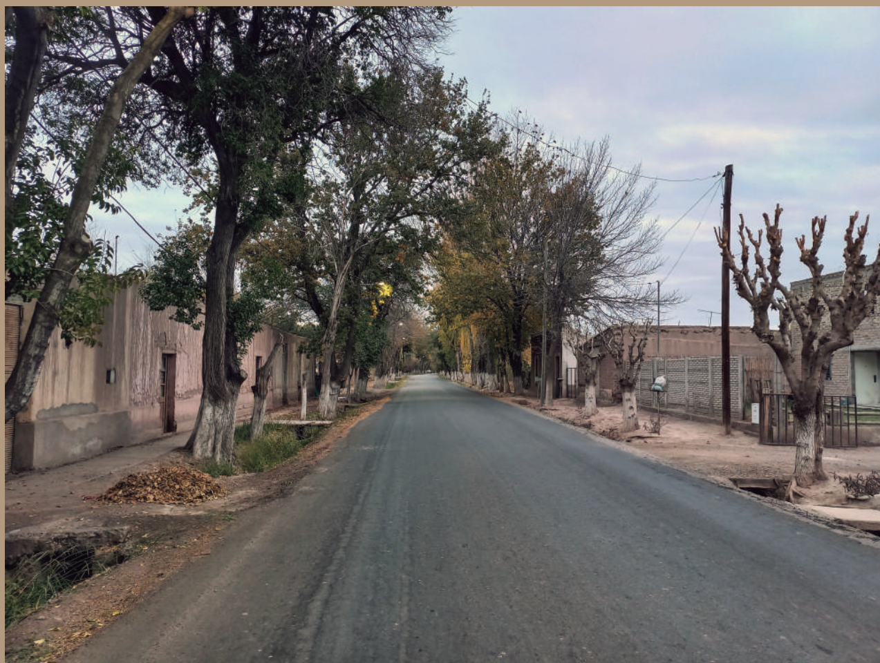
Eje estructurante histórico: calle Lamadrid en las proximidades de la plaza central y la intersección con el Carril Nacional Viejo. Fuente: arq. Paula Martedi.
