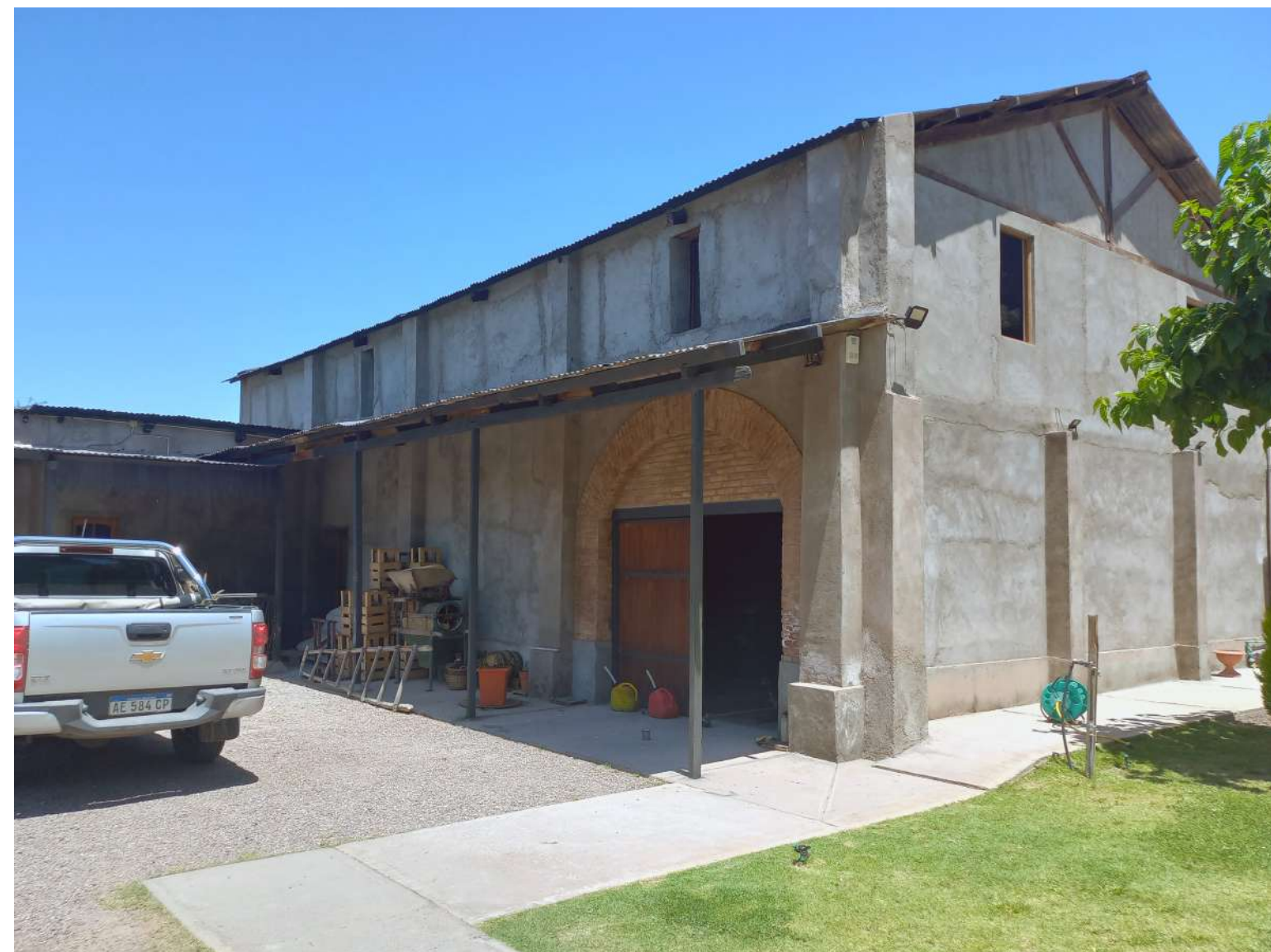
Vista de nave principal de bodega. Fuente: arq. Paula Martedi.
