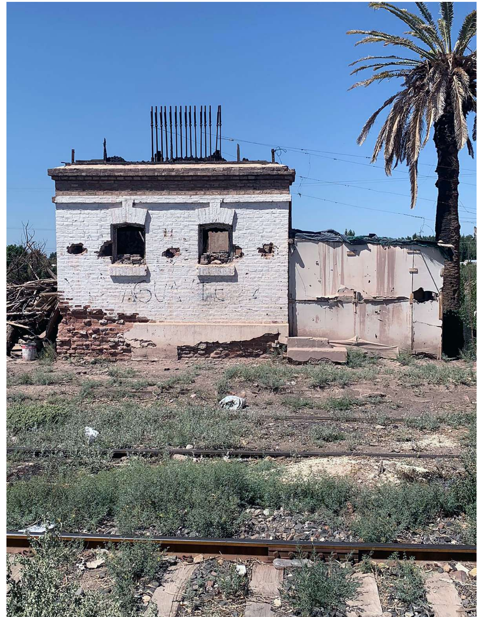
Garita guardabarreras de la estación Barcala. Fuente: arq. Paula Martedi
