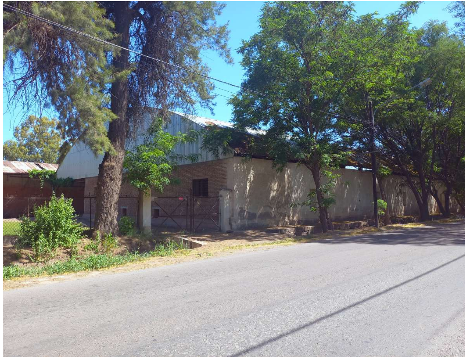
Naves de bodega. Fuente: arq. Paula Martedi.
