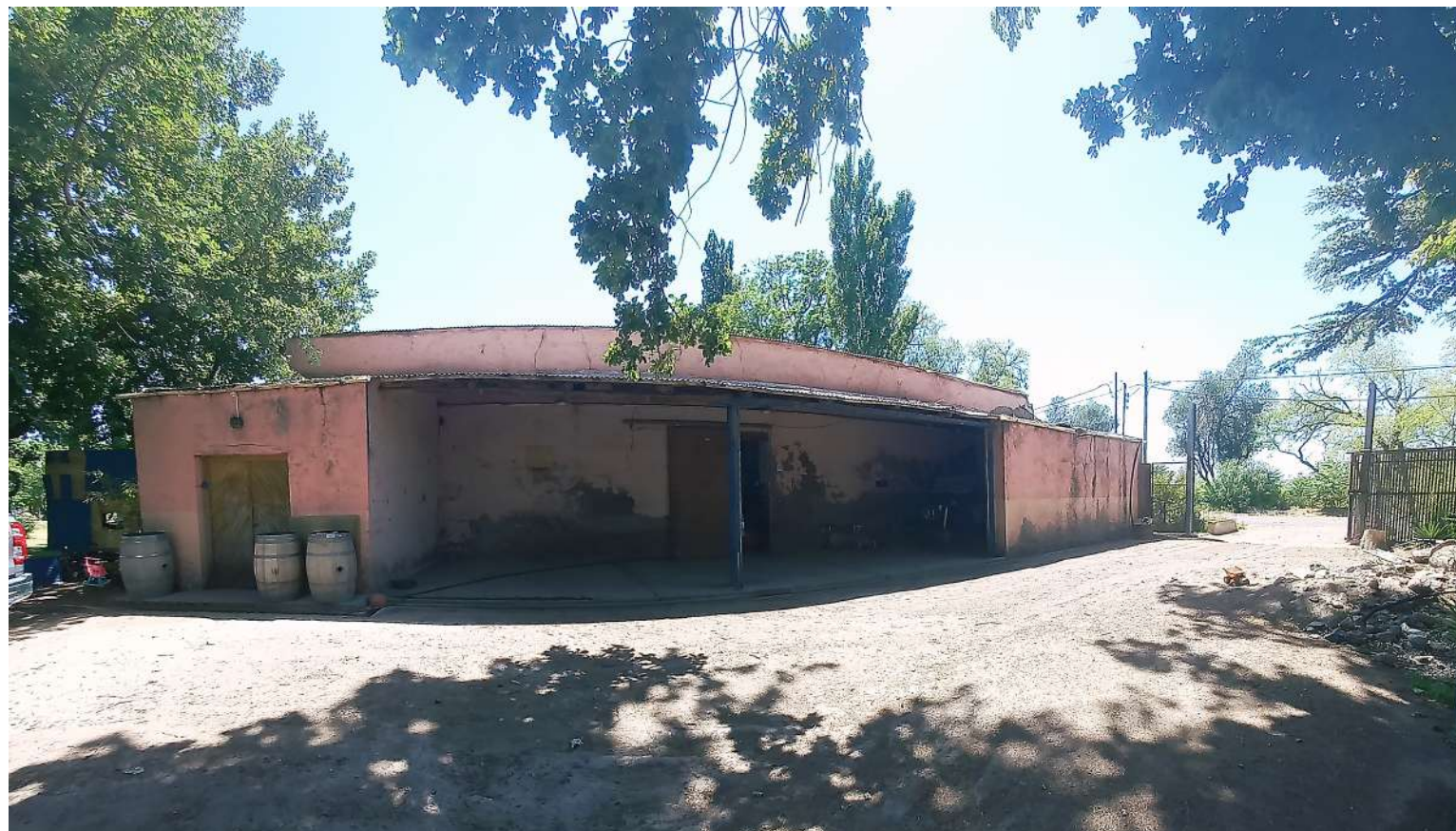
Vista lateral de bodega. Fuente: arq. Paula Martedi.
