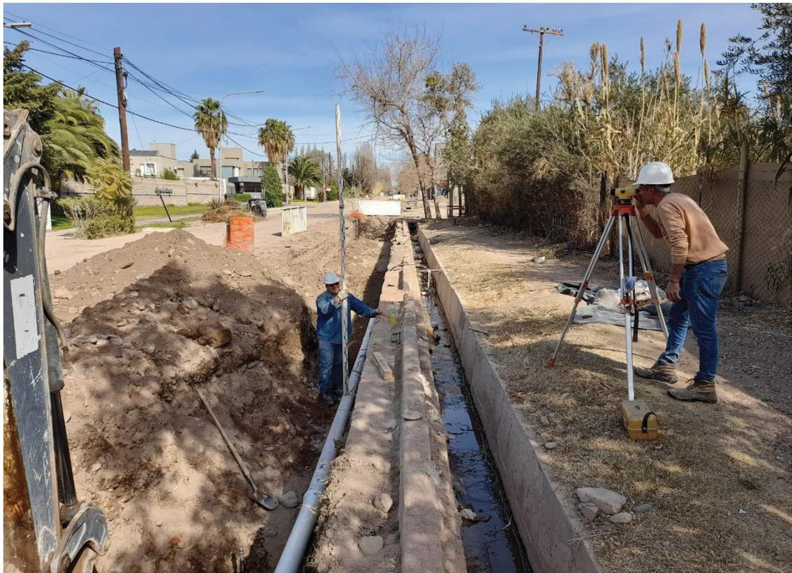
*Figura 23: Instalación de cañería subsidiaria de PVC cloacal DN 160 mm sobre calzada con una tapada mínima de 1,40 m y control de nivelación para dar una pendiente que garantice la capacidad de conducción y asegure la autolimpieza de la cañería*
