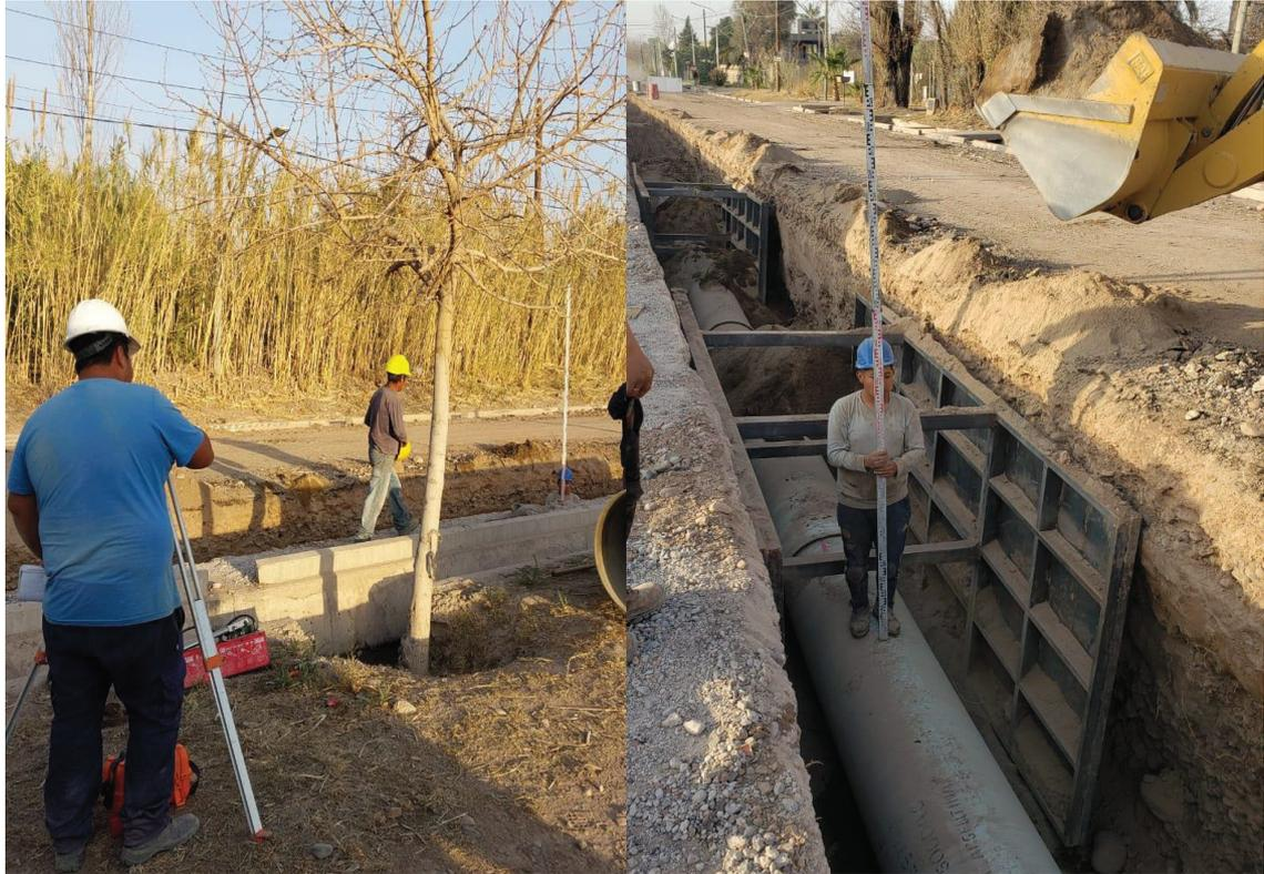
Figura 25: Control de nivelación final de cañería
