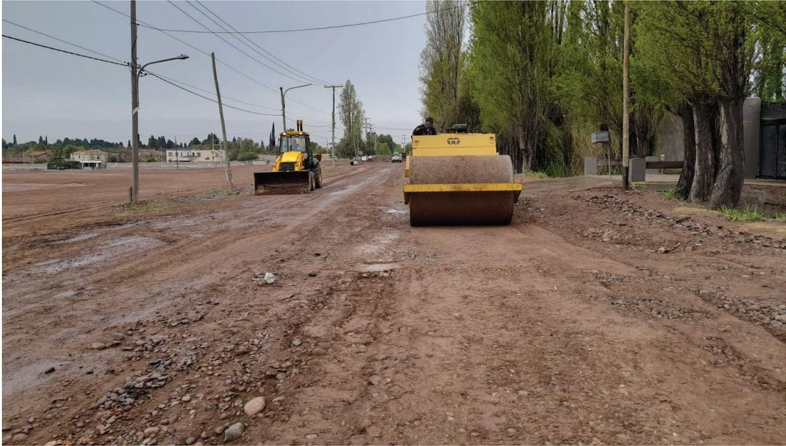
*Figura 40: Rodillo vibratorio liso de 8 ton. La capacidad vibratoria lo vuelve apto para suelos granulares, especialmente gravas. También es apropiado para terminación superficial, arenas y parcialmente en arcillas*
