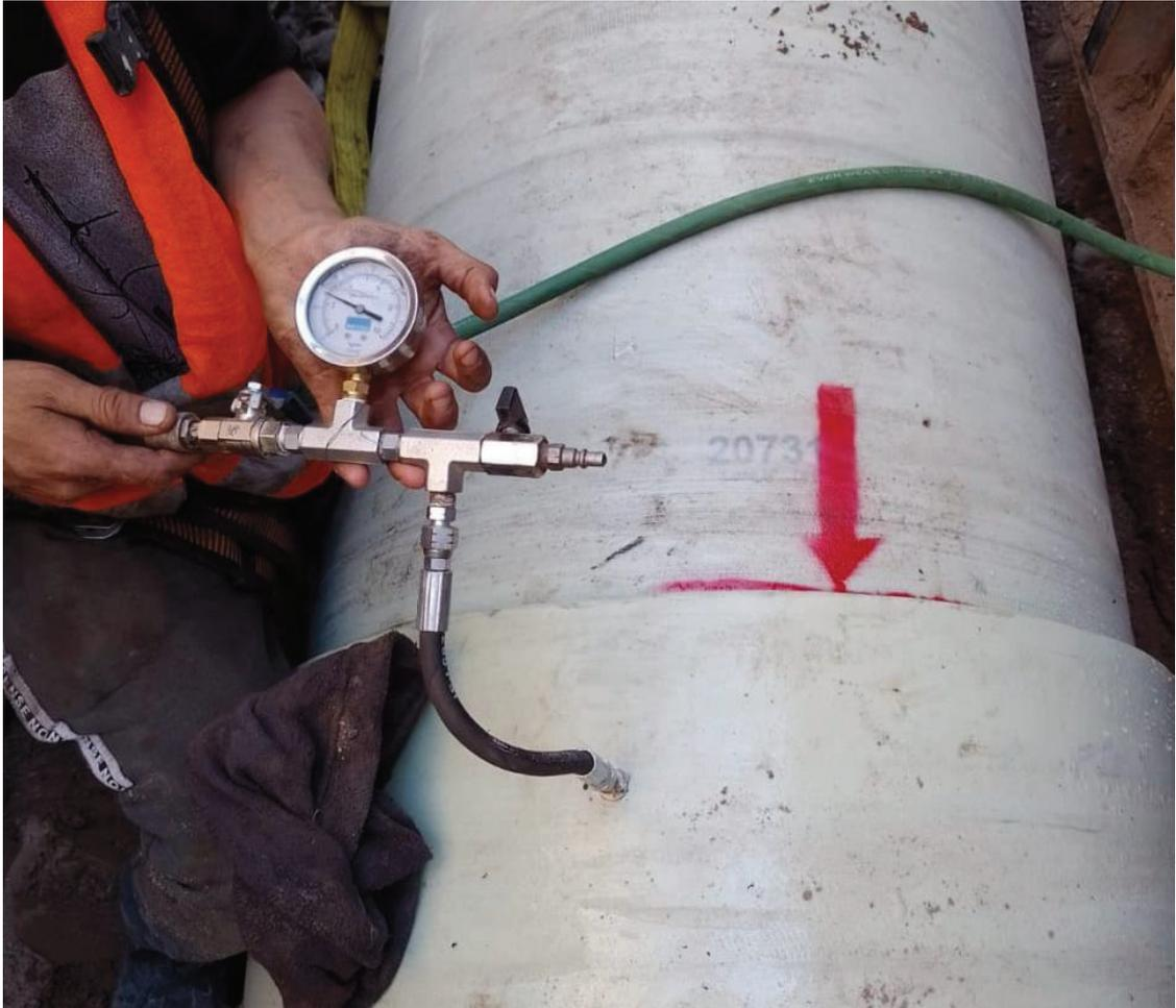
Figura 14: Prueba hidráulica para verificación de estanqueidad de la unión de dos cañerías
