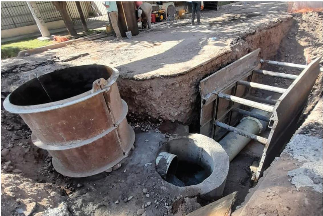
Figura 58: Bocas de registro auxiliares para empalme construidas una sobre colectora existente (izquierda de la imagen) y la otra para reorientar los líquidos en dirección de la nueva colectora (centro de la imagen)
