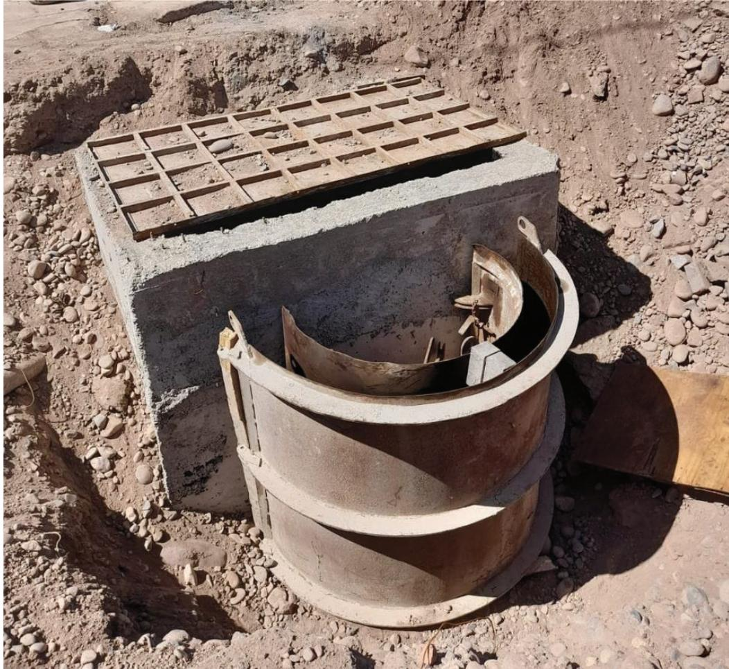
Figura 53: Encofrado para la construcción de una fracción de boca de registro por encima del colector existente y adherida a la cámara de la nueva colectora construida previamente al norte de Adolfo Calle
