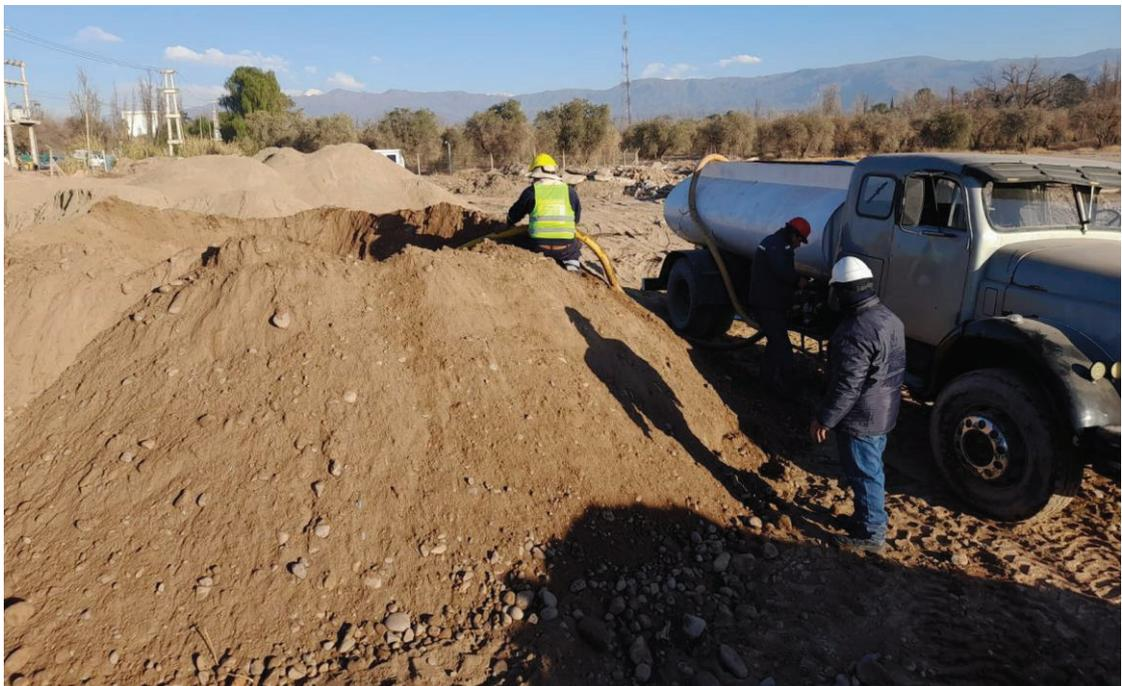
*Figura 35: Humectación de pilas de material en playas de acopio. Luego se mezcla el material con el empleo de equipos para uniformar el contenido de humedad en todo su volumen*
