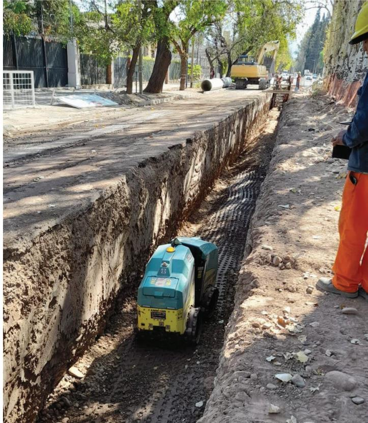
*Figura 38: Rodillo pata de cabra vibratorio a radio control. Son tambores con gran número de protuberancias, que compactan de abajo hacia arriba. Tienen su mayor efectividad en la compactación de suelos arcillosos, aunque demuestran buenos resultados también en suelos granulares por su capacidad vibratoria. Por poder comandarse a distancia brindan una buena solución para la compactación de zanjas profundas sin el empleo de entibado, que muchas veces dificulta la misma compactación*
