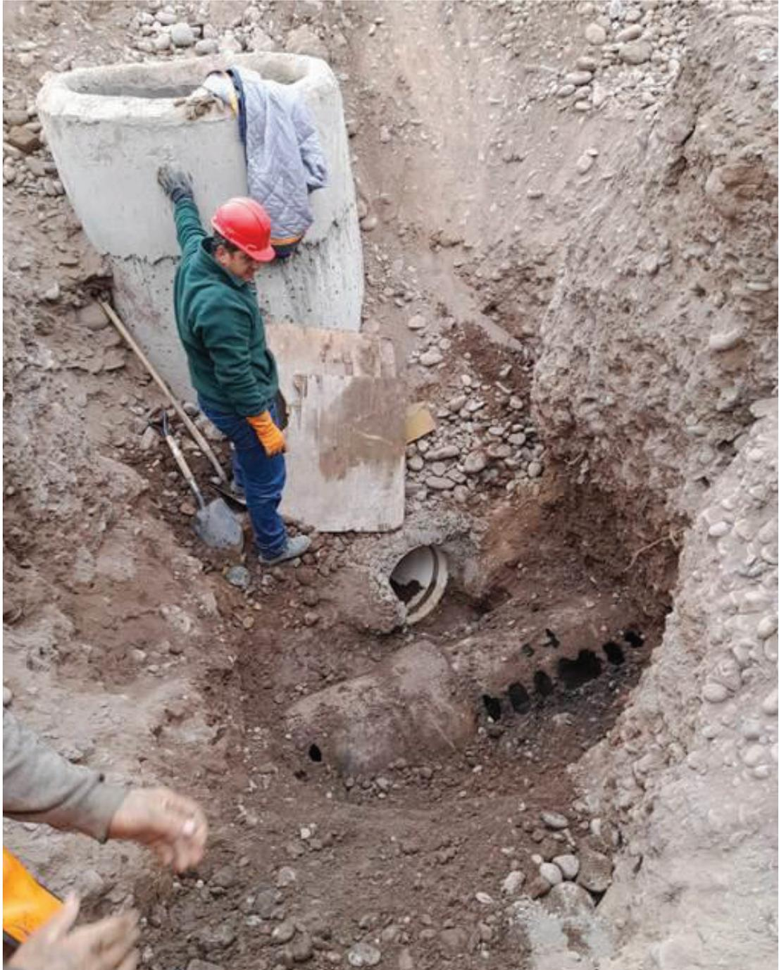
*Figura 51: Grado de deterioro muy avanzado observado sobre el colector existente producto de la acción de los gases generados por la descomposición de la materia orgánica*
