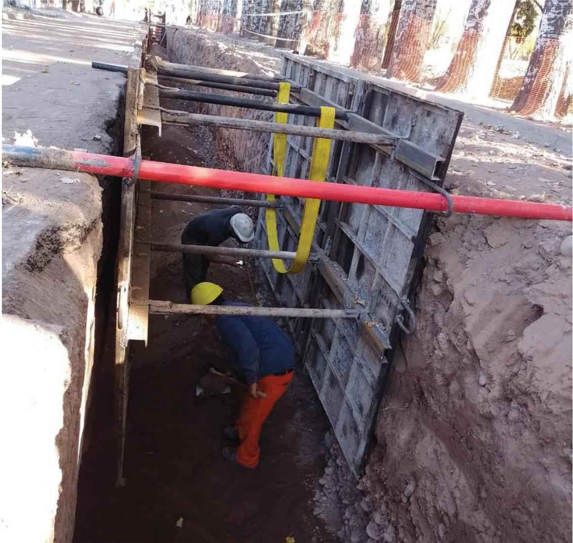
*Figura 28: Entibado suspendido con tubos estructurales. Como se observa, este método garantiza una altura superior por encima del nivel de terreno, no así una profundidad libre suficiente en todos los casos para ejecutar el relleno de primera etapa (varía en función de la profundidad de la zanja respecto de la altura del molde). Esta dificultad se puede salvar en parte disponiendo de puntos de amarre a diferentes niveles, como se observa en esta figura*
