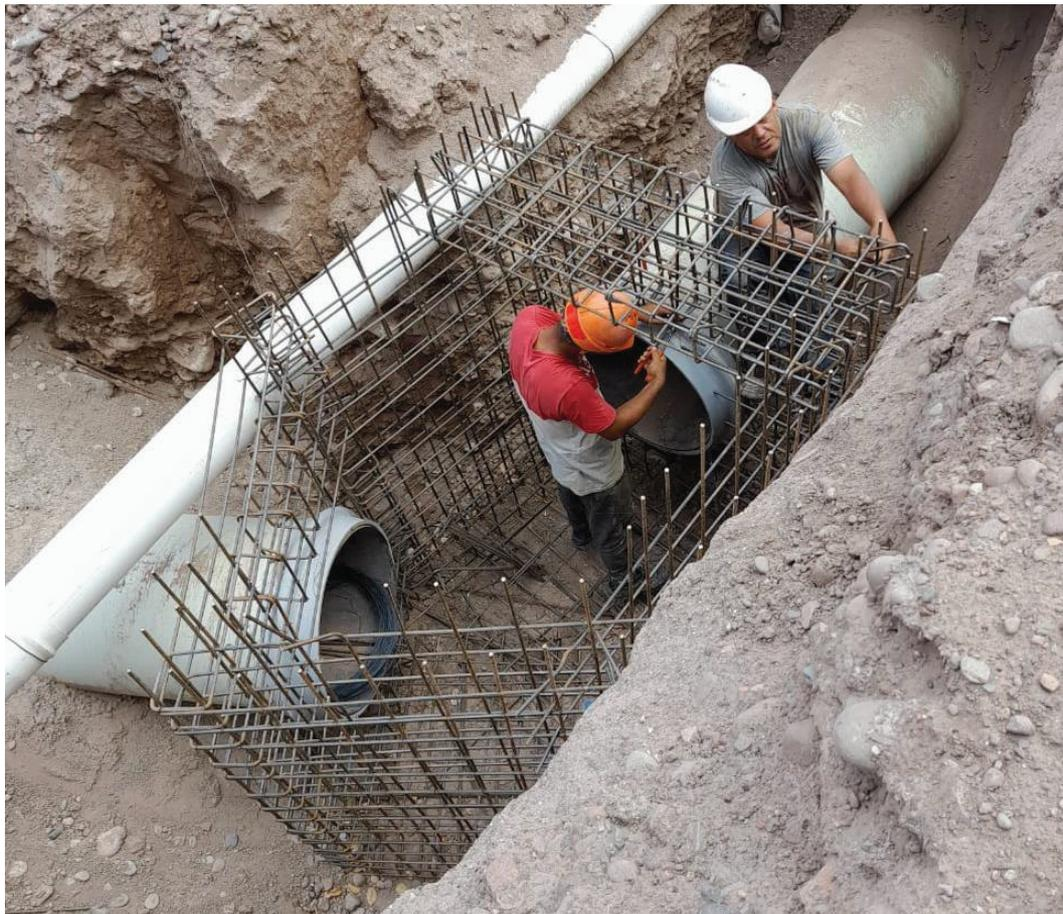
*Figura 46: Ejemplo de armado de boca de registro para salvar cambio de dirección y salto de nivel de cañerías de entrada y salida a la misma*
