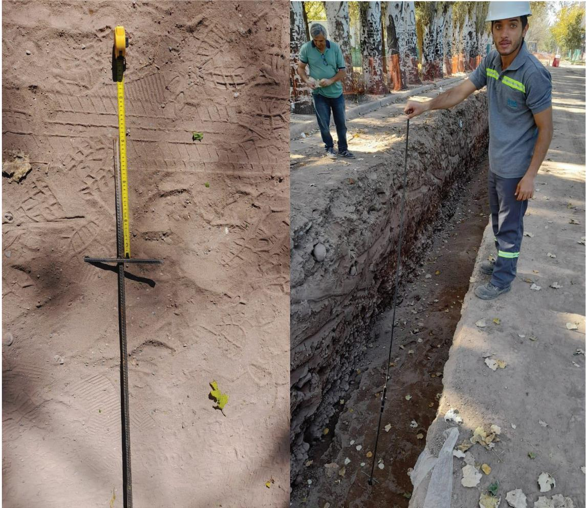
*Figura 32: Punzón casero con marca de profundidad de 30 cm para control expeditivo del espesor de capa del relleno de primera etapa. Se introduce suavemente hasta hacer contacto con el lomo del caño; si el punzón penetra hasta la marca o más, significa que el relleno de primera tiene por lo menos un espesor de 30 cm*
