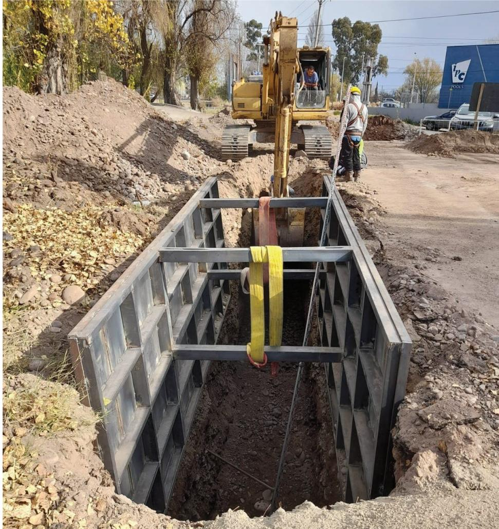
*Figura 29: Entibado de amplitud variable (creciente) en altura. Se excava un ancho de zanja apenas superior a la apertura inferior del molde y luego se hinca el molde de contención sobre el terreno con ayuda del balde de la excavadora, quedando suspendido a una cierta altura y garantizando un espacio libre en la parte inferior donde se ejecuta el relleno de primera etapa*
