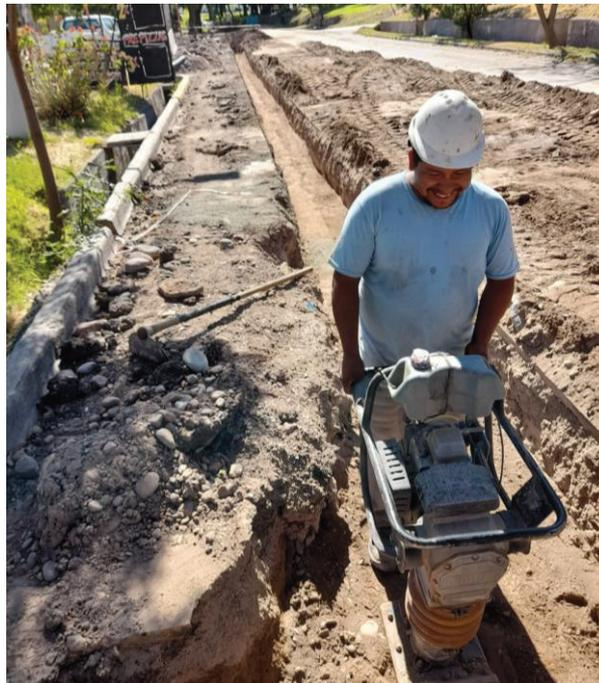
*Figura 39: Pequeño compactador manual (“canguro”). Son eficientes para pequeños rellenos cohesivos, como ser las zanjas angostas por encima de las cañerías de agua o redes cloacales subsidiarias. Ha sido demostrado que los métodos de impacto son inefectivos para el caso de suelos granulares. Además por requerir la presencia de un operador no resultan útiles para la compactación de zanjas profundas*
