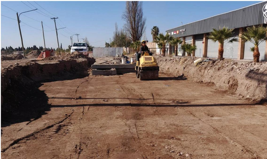
*Figura 41: Rodillo vibratorio liso de 2,5 ton. La capacidad vibratoria lo vuelve apto para suelos granulares, especialmente gravas. También es apropiado para terminación superficial, arenas y parcialmente en arcillas, aunque es menos efectivo que el anterior por poseer un ancho de rodillo menor que muchas veces no abarca la sección completa a compactar, debiendo solapar pasadas para cubrir toda la cancha*
