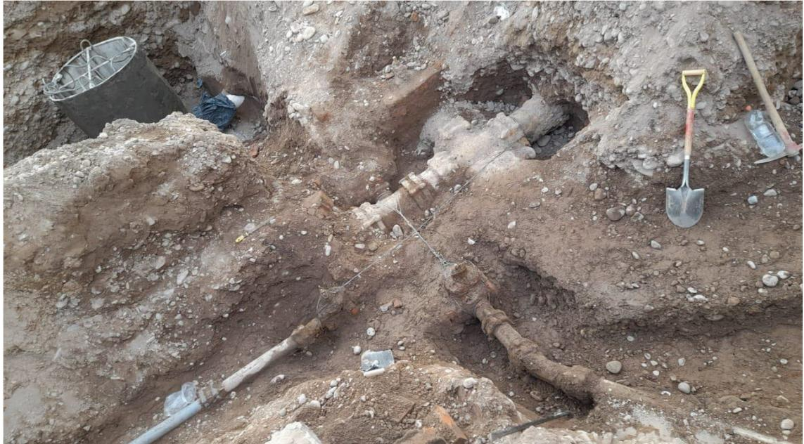
*Figura 24: Sondeo de instalaciones existentes con el uso de herramientas menores*
