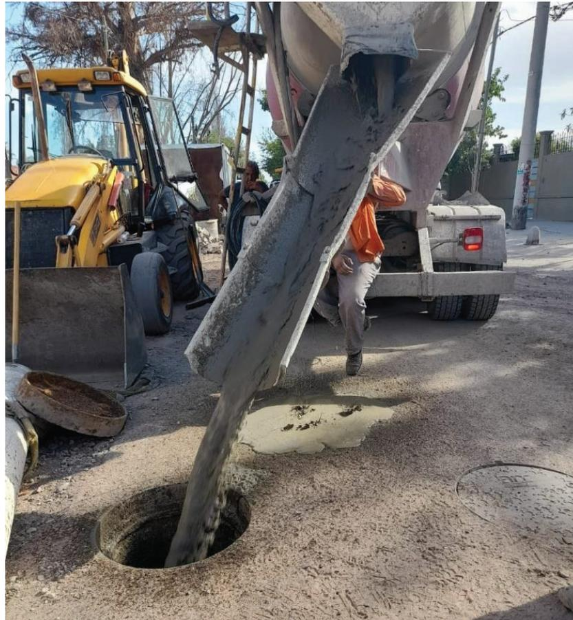
*Figura 64: Llenado interior con RDC de colectora existente sacada de servicio para su cegado*
