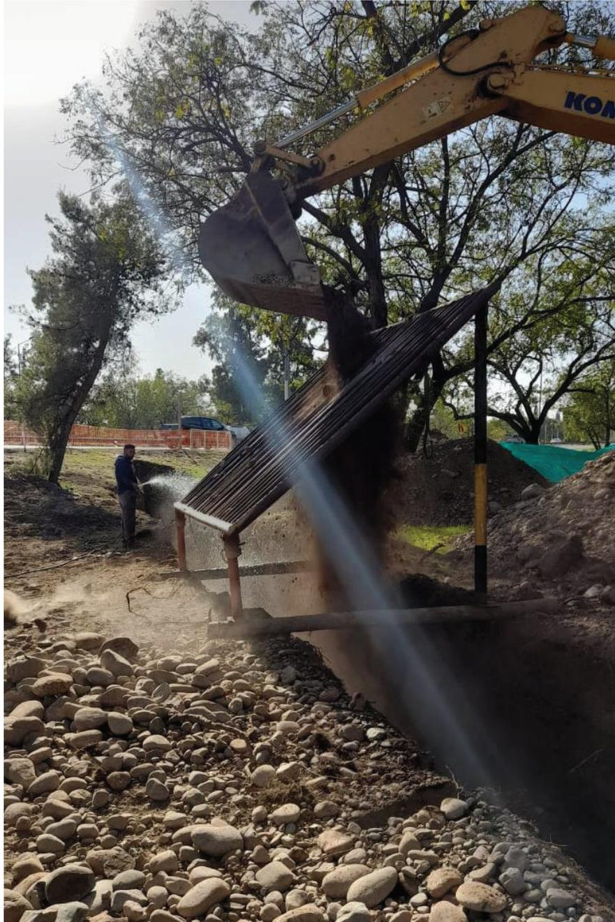
*Figura 33: Cribado in situ sobre la superficie de la zanja. Se humedece en simultáneo de forma continua*
