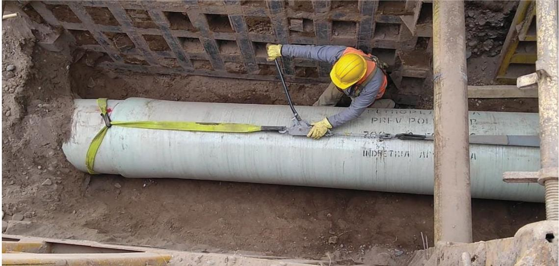
*Figura 13: Proceso de enchufado mediante tensores mecánicos (malacate)*
