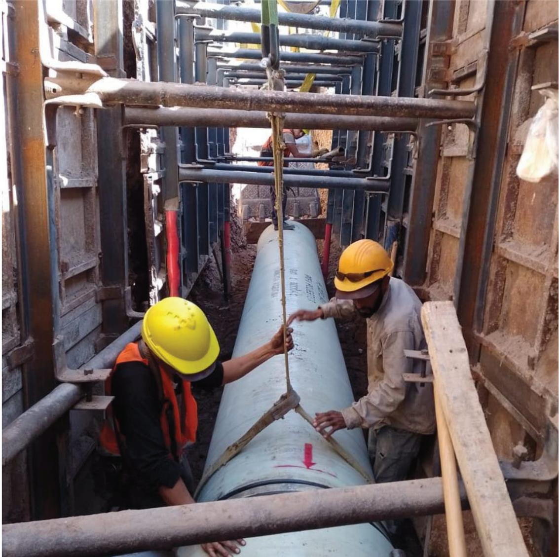
Figura 9: Proceso de enchufado mediante empuje con balde de equipos de excavación interponiendo un tablero de madera para protección mecánica de la cañería
