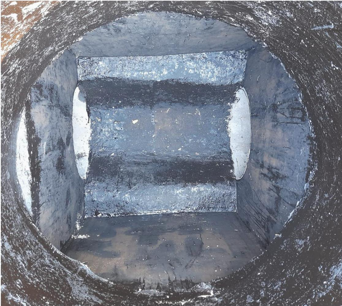
*Figura 49: Terminación interior de bocas de registro. Para brindar una barrera adicional de protección química tanto de hormigón como de armaduras, se aplican dos manos de pintura epoxi bituminosa apta para estar en contacto con líquidos cloacales*
