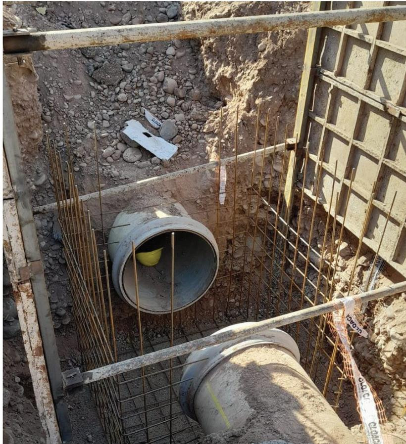
*Figura 21: Vista de los extremos de cañería de entrada y salida a una boca de registro en proceso de armado. Se observa cómo el empotramiento de las mismas a la estructura de hormigón queda materializado mediante el empleo de manguitos de empotramiento*
