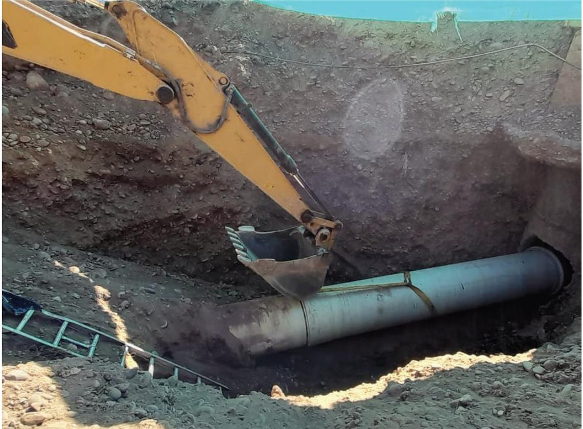
*Figura 11: Proceso de enchufado mediante equipos y elementos de izado de tubos*
