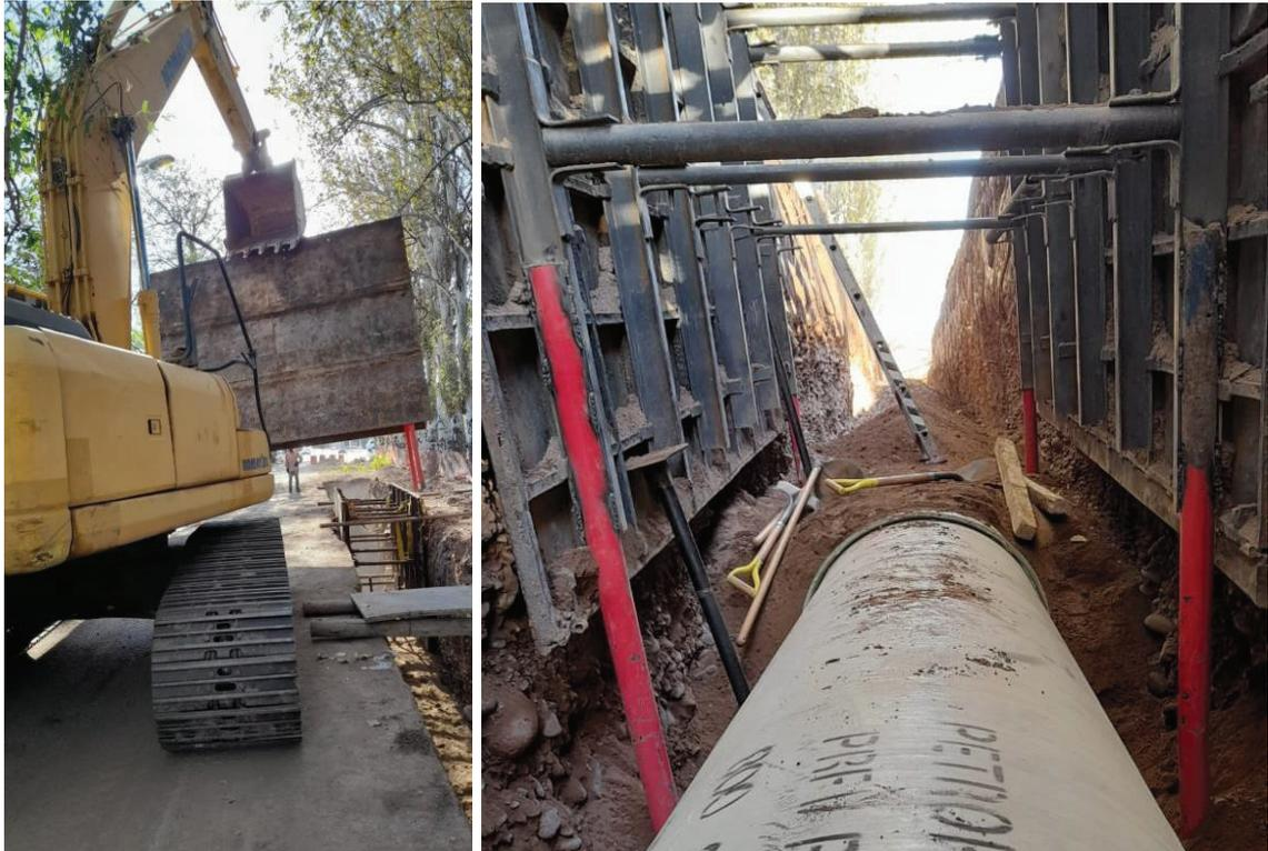
*Figura 27: Entibado con soportes inferiores. Representan una buena alternativa siempre que no se cuente con interferencias aéreas que dificulten su traslado y manipulación*
