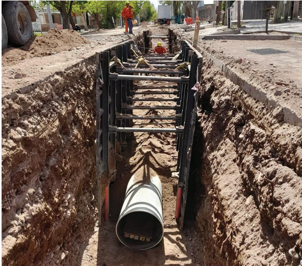
*Figura 26: Entibado con sección continua en toda la profundidad de la zanja (no recomendado). Éste se debe mantener hasta completar la compactación manual mediante pisones del relleno de primera etapa hasta 30 cm por encima del extradós del caño. Al retirar el molde luego, se altera la compactación, quitando apoyo a la tubería*
