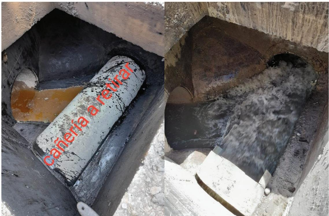
Figura 62: Cañería de PRFV DN 600 mm a retirar (izquierda) y retirada (derecha) en BR 31 (inmediaciones de Estrada y P. Vargas)
