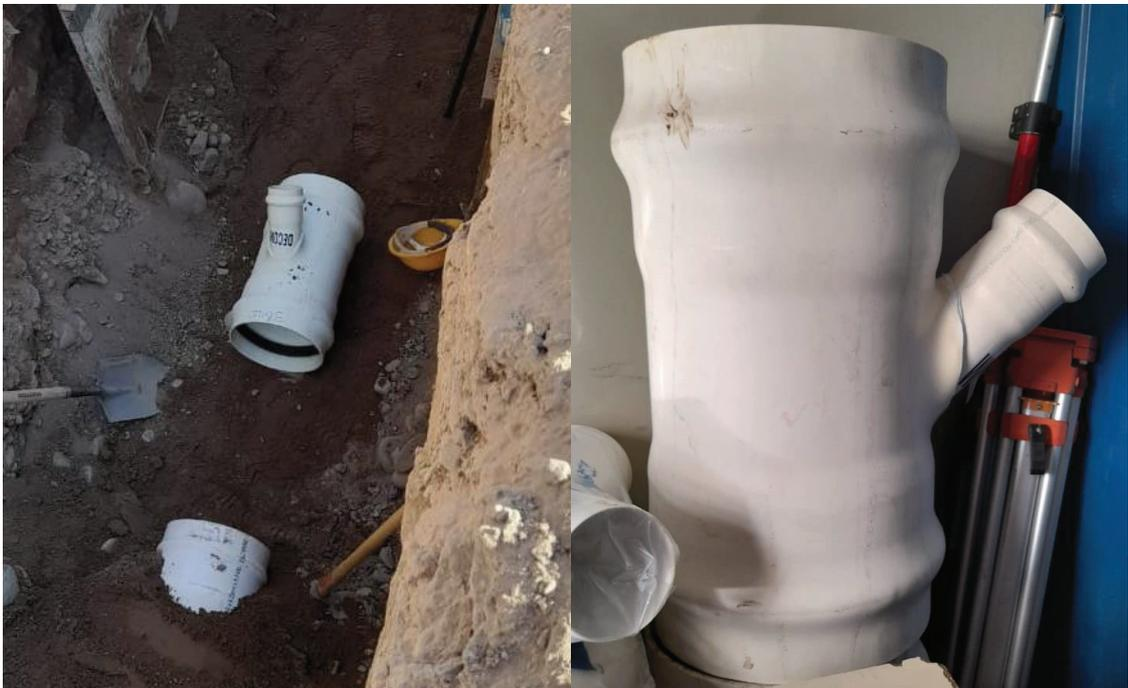
*Figura 22: Ramal a 45° de PVC cloacal con junta elástica empleado para realizar la conexión domiciliaria a la red. Se emplaza dicho ramal en coincidencia con el punto donde se prevé que desemboque una red domiciliaria. El de la imagen corresponde a un ramal a 45° de PVC cloacal 315 x 110 mm, ramal que es necesario utilizar para conectarse directamente sobre una cañería de PVC cloacal DN 315 mm, con el elevado costo que ello implica*
