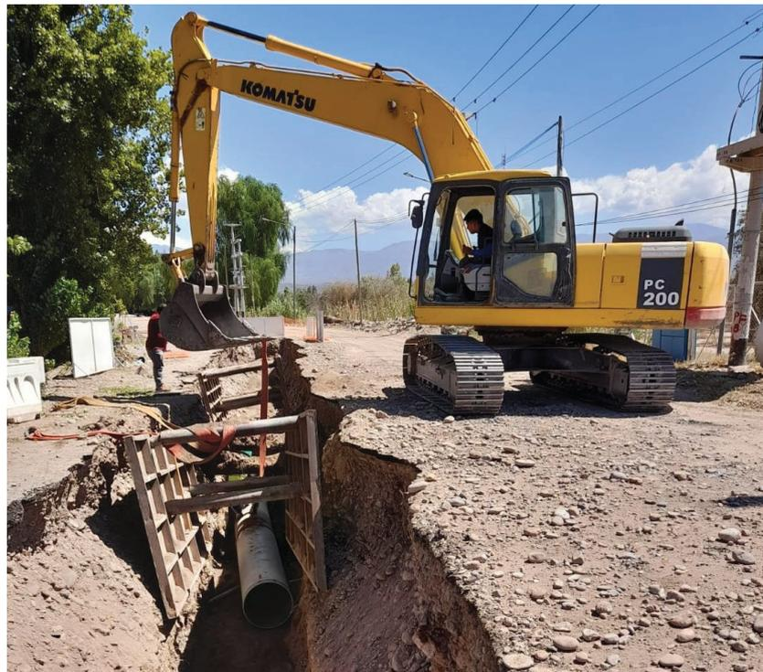
Figura 6: Izamiento de cañerías y ubicación en zanja mediante el empleo de eslingas de nylon que prenden del balde de los mismos equipos de excavación
