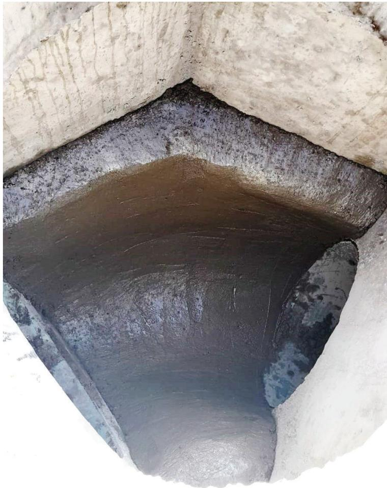
*Figura 47: Vista interior de boca de registro. Se observa que la construcción del cojinete respeta una altura mínima de hasta por lo menos el nivel del intradós de la cañería y desde allí mantiene hasta hacer contacto con los muros laterales una pendiente mínima que garantiza su autolimpieza*
