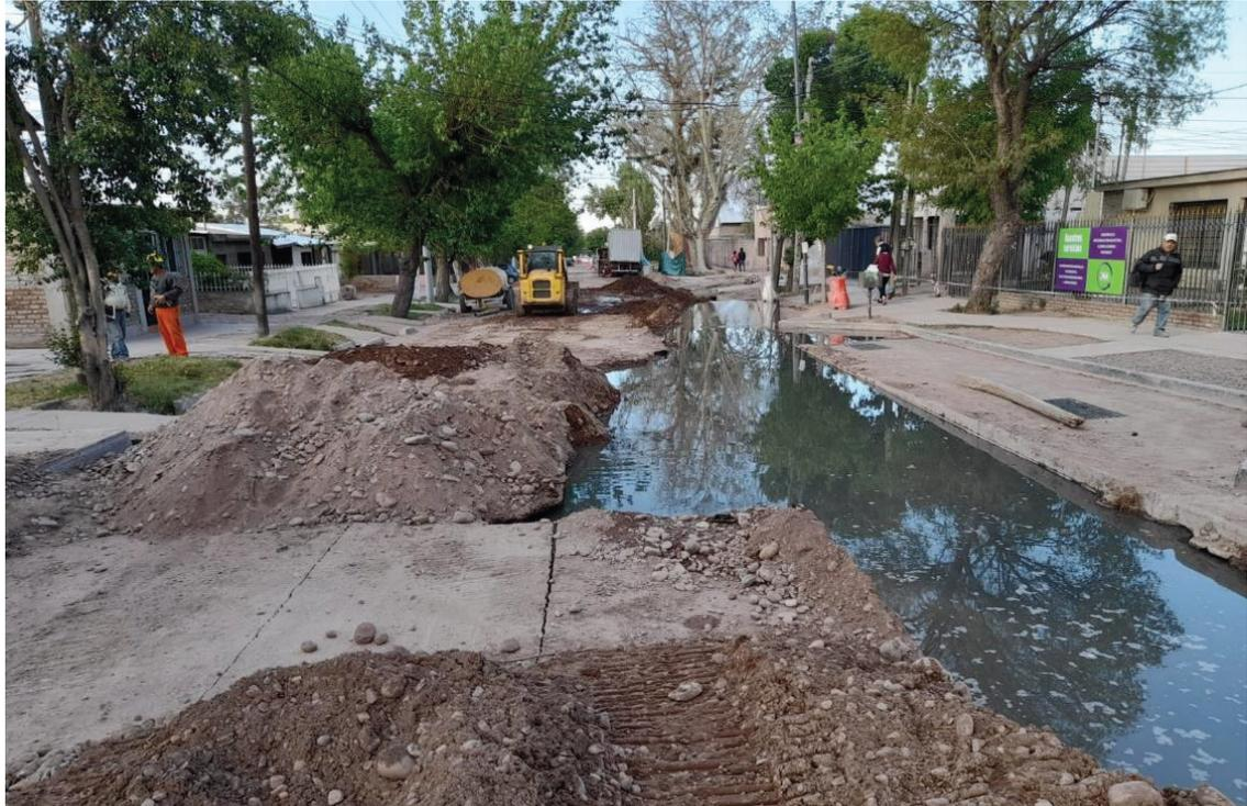
*Figura 52: Desborde de líquidos cloacales por colapso de colector existente en Estrada, entre Gualberto Godoy y Charcas*
