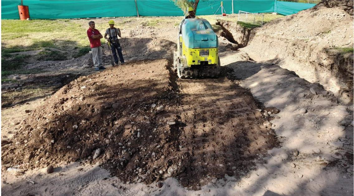
*Figura 43: Terraplén de prueba practicado con material seleccionado del lugar empleado como relleno de segunda con un contenido de humedad cercano a la óptima. En este caso se dio a toda la superficie el mismo número de pasadas y se extrajo muestras de distintos espesores de capa, para determinar el grosor máximo con el que se podía obtener la densidad de compactación mínima requerida*
