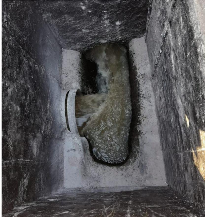
Figura 55: Desvío provisorio de líquidos cloacales al norte de Adolfo Calle y Estrada hacia la nueva colectora de PRFV colocada aguas abajo de dicho punto
