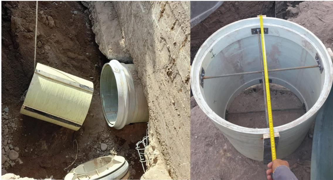
*Figura 16: Prueba de inalterabilidad de la sección en un tramo de cañería. El diámetro del tapón es 5% menor al diámetro interior de la cañería probada*
