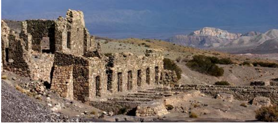
Figura 8. Planta de tratamiento del pique Gobernador en MPU
